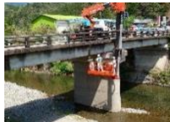
インフラの維持管理(点検作業)
