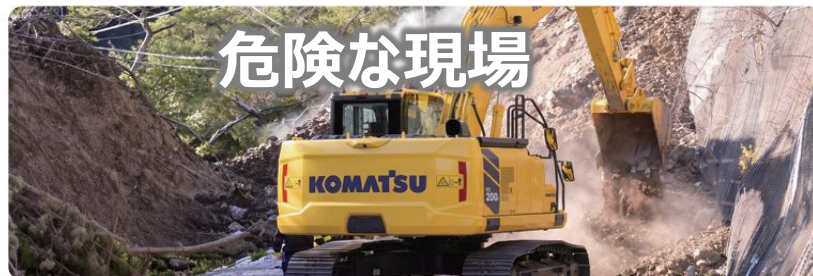
| 災害復旧工事
