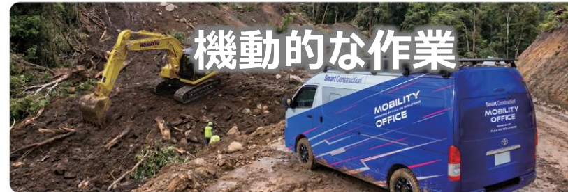
| オフィス機能を持った車両を用いての遠隔施工・現場管理
