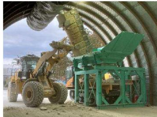
ずりのすくい上げ、走行、投入を自動化（ホイールローダ）
