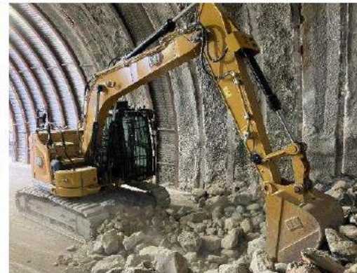
走行、ずりの移動を自動化（バックホウ）
