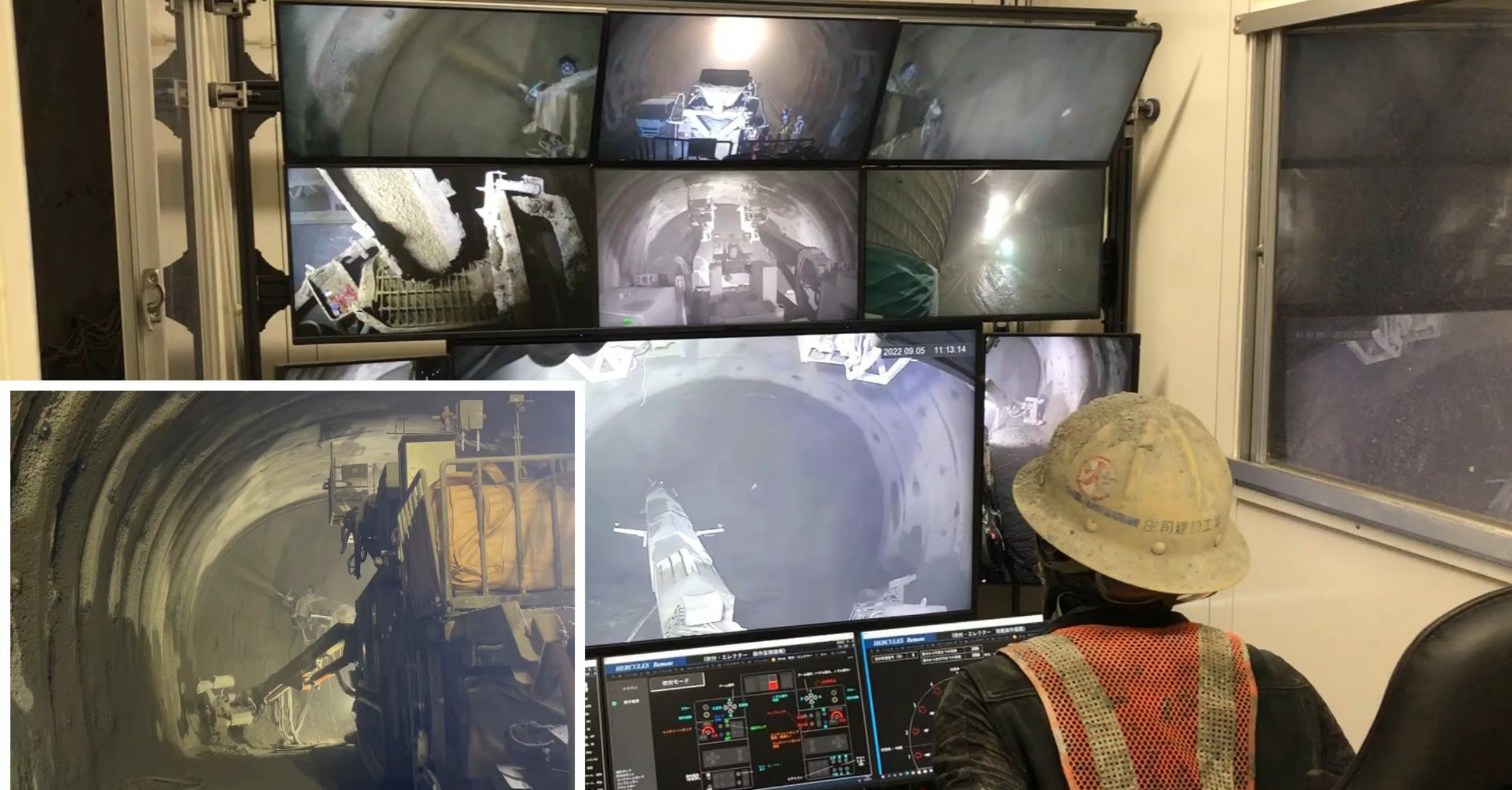
吹付機遠隔操作システム（ Tunnel RemOS-Spray ）試行状況動画
